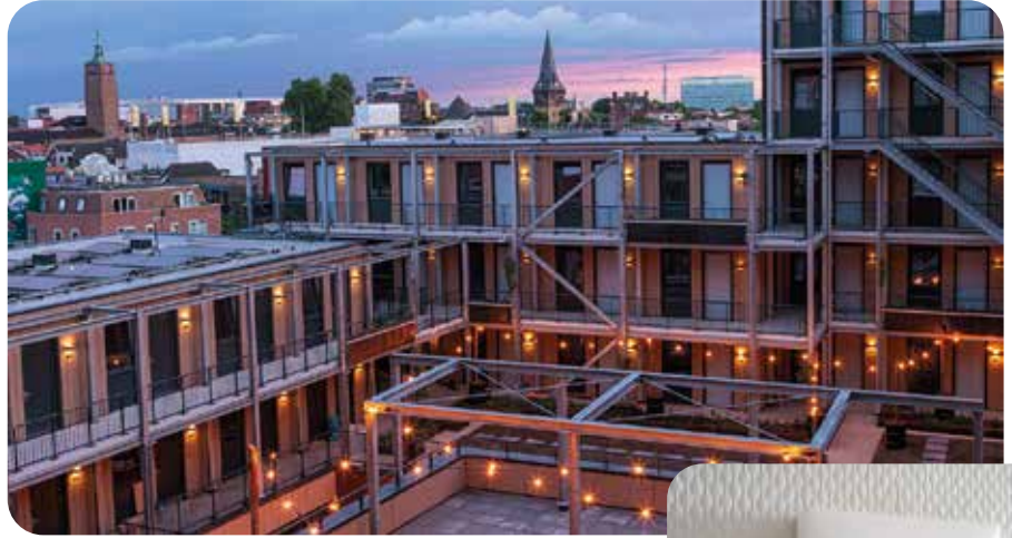
Bundle@Performance Factory: Ein innovativer Wohn- und Arbeitskomplex mit 202 vorgefertigten Studios im niederländischen Enschede.
