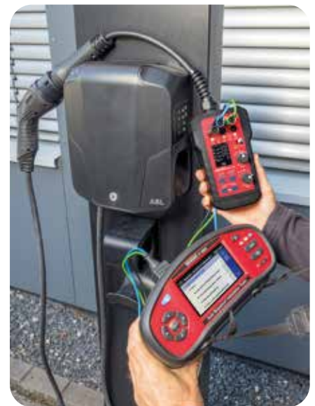
Prüfung EV Ladestation (Wallbox) mit Hilfe des optionalen BENNING EV 3-3
