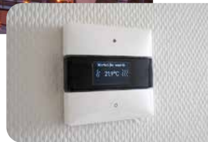
Mit dem Raumcontroller LUXORliving iON8 lassen sich Funktionen wie Schalten, Dimmen, Jalousie, Szene und Temperaturregelung einfach bedienen.
