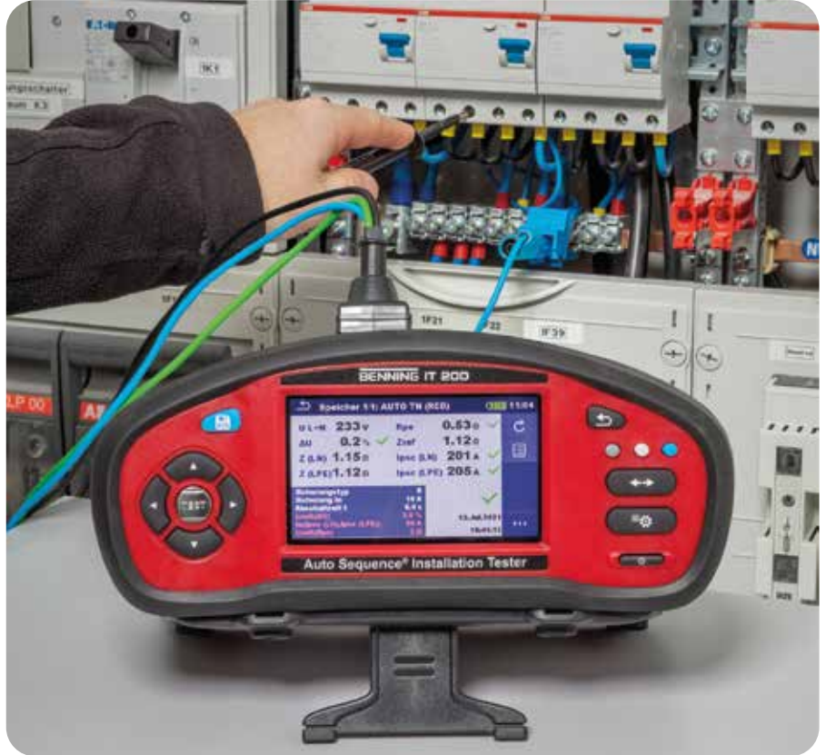
Installationstester BENNING IT 200 bei der Prüfung einer elektrischen Anlage
