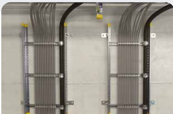
Kombiniert zwei Produktserien: Die Kabel- und Steigeleiter KSL
